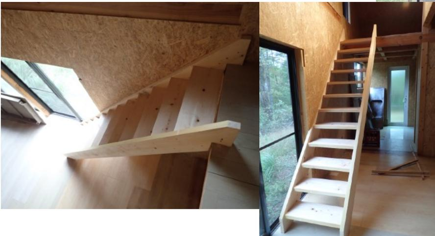
三人のチームワークと腕力で「えいや〜」と先端部分をロフトまで持ち上げて、設置に成功！120mmビスで固定すれば完成です。桧材で作った階段はきしみもなく完璧です。
